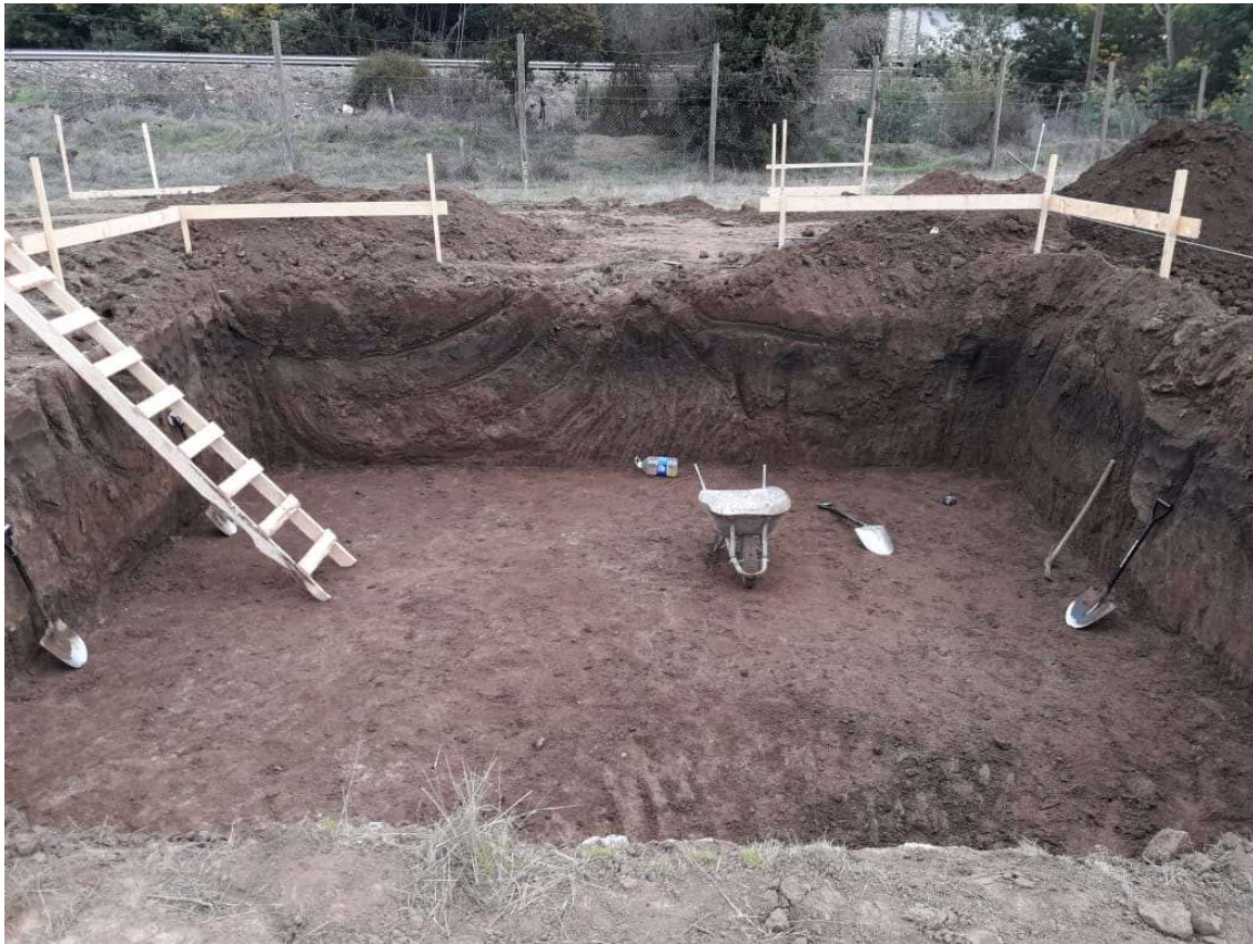
Fotografía 5: Sello de fundación de edificio principal.
