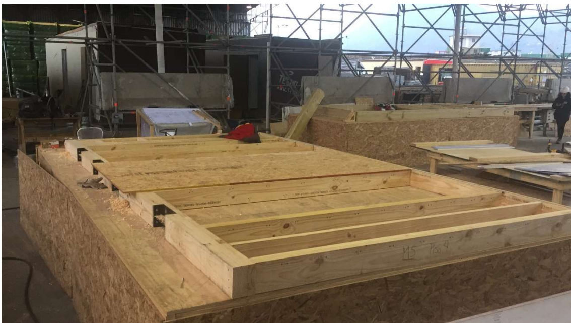
Fotografía 1: Fabricación de entramados de muros.
