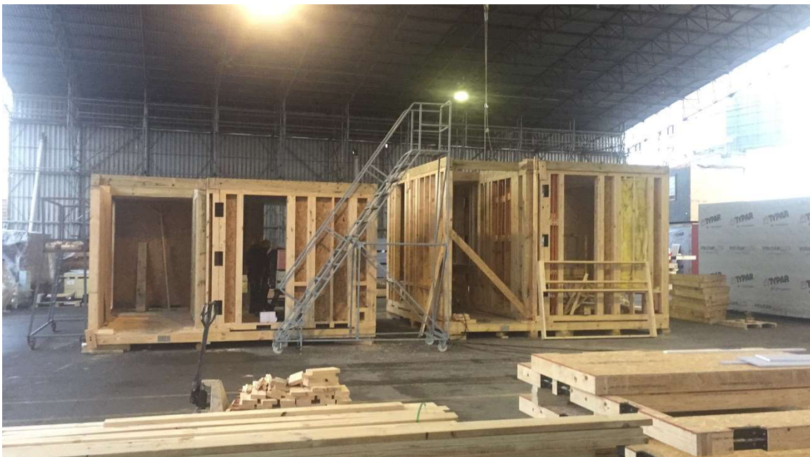
Fotografía 3: Pisos 1 y 2 montados.
